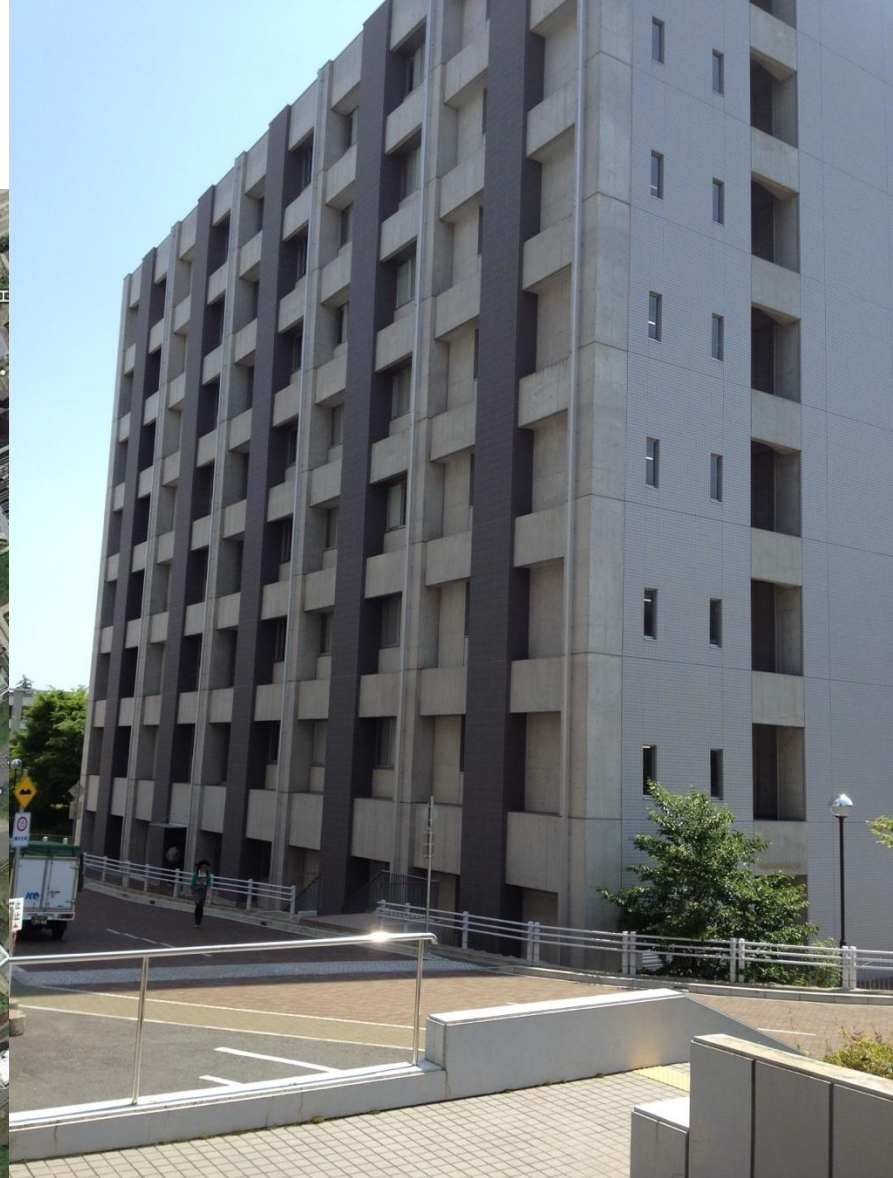
自然科学総合研究棟 4号館
