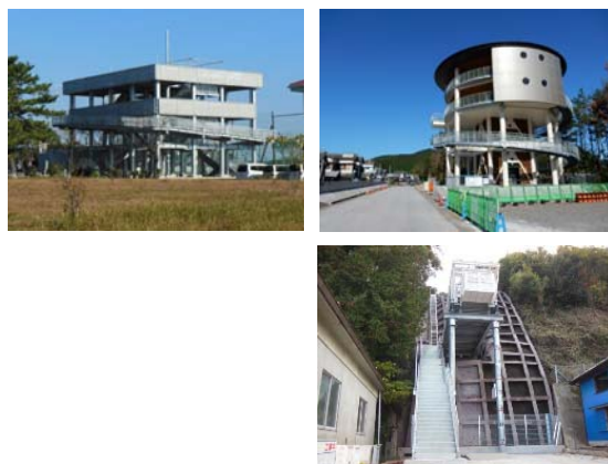
写真 1 左上：種崎地区津波避難タワー（高知市）、右上：中土佐町 1 号津波避難タワー（中土佐町）、右下：山路地区津波避難タワー（四万十市）
